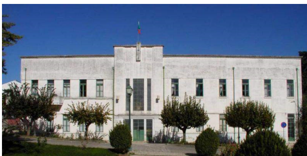
Edifício propriedade da Câmara Municipal
