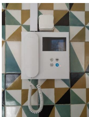
Procedeu-se à instalação na entrada do piso 1 (local de acesso a pessoas com mobilidade reduzida), de um sistema de videoporteiro, de forma a permitir que aquelas acedam às instalações, com prévio alerta ao segurança da necessidade da abertura da porta
