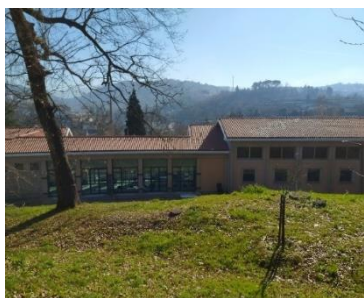
No decurso do corrente ano, foram realizados trabalhos de reabilitação da cobertura deste Palácio da Justiça, com aplicação de telha nova, pelo IGFEJ.
