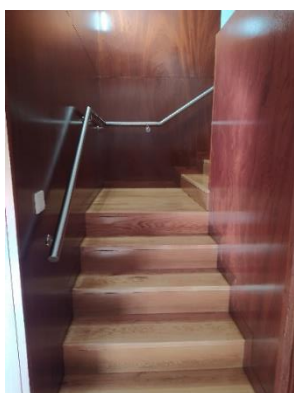
Efetuuou-se a manutenção da escadaria interior em madeira à colocação de um corrimão, conforme anotação feita no relatório de segurança e saúde no trabalho.
