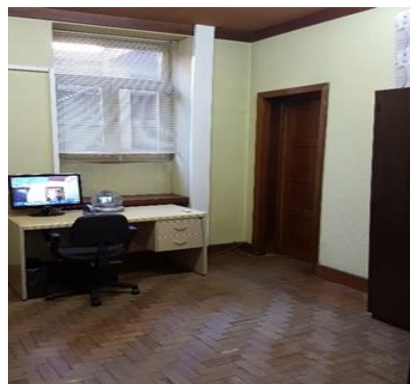
Novas instalações da sala de videoconferências
