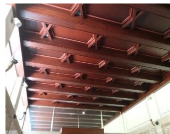
Foram, também, realizados trabalhos de carpintaria do teto interior da sala de audiências (I.G.F.E.J)
